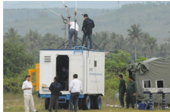
Gambar 4-1: Pemasangan sistem telemetri
