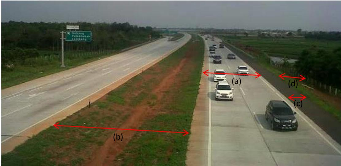
Gambar 3-8: Kenampakan jalan bebas hambatan Cipali di lapangan yang terdiri atas jalur-jalur (*in* dan *out*) yang masing-masing terdiri atas dua lajur (a), satu median jalan (b), bahu jalan (c), dan saluran tepi/samping (d)
